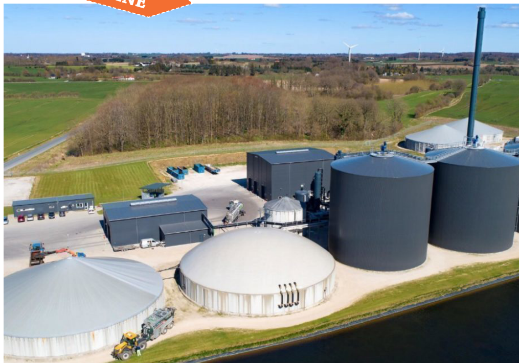
Une usine de méthanisation.
